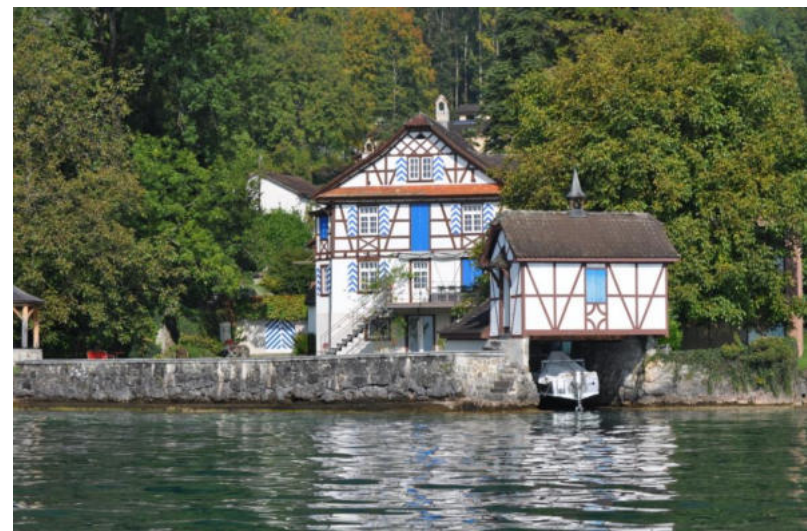
Seestrasse 84.2, Bootshaus Seewarte, Ansicht von W (Aufnahme 2011)
