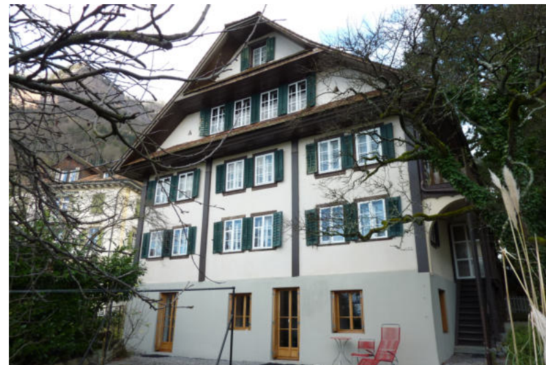
Seestrasse 62, Seerose, Ansicht von W (Aufnahme 2012)
