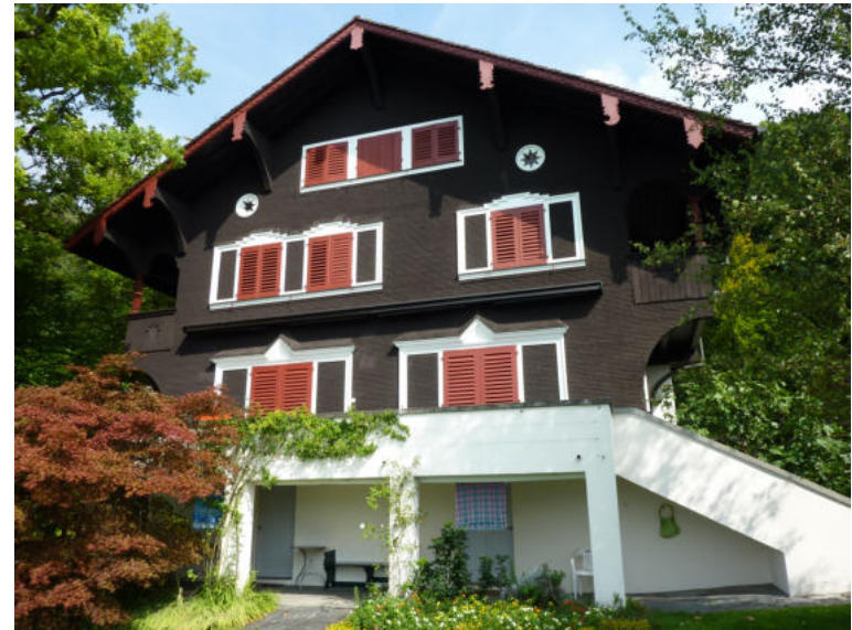
Seestrasse 6, Lausiegg, Ansicht von W (Aufnahme 2011)
