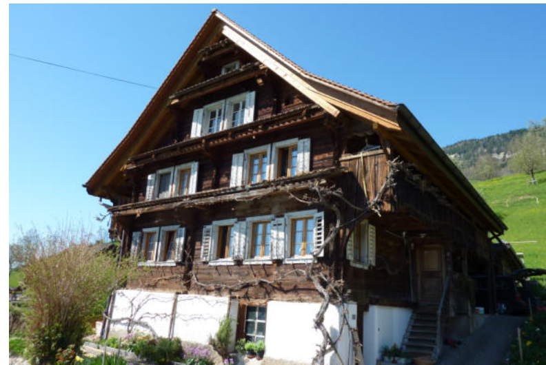
Acherweg 2, Ansicht von SO (Aufnahme 2011)
