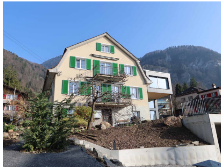
Altdorfstrasse 5, Neubühl, Ansicht von NW (Aufnahme 2024)
