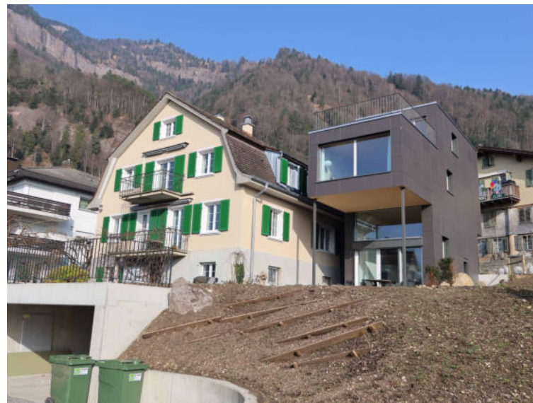
Altdorfstrasse 5, Neubühl, Ansicht von W (Aufnahme 2024)
