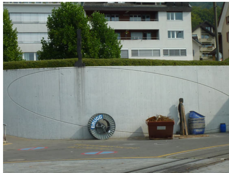
Bahnhofstrasse N.N., Kunst am Bau, Ansicht von W (Aufnahme 2011)
