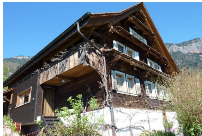
Acherweg 2, Ansicht von SW (Aufnahme 2011)
