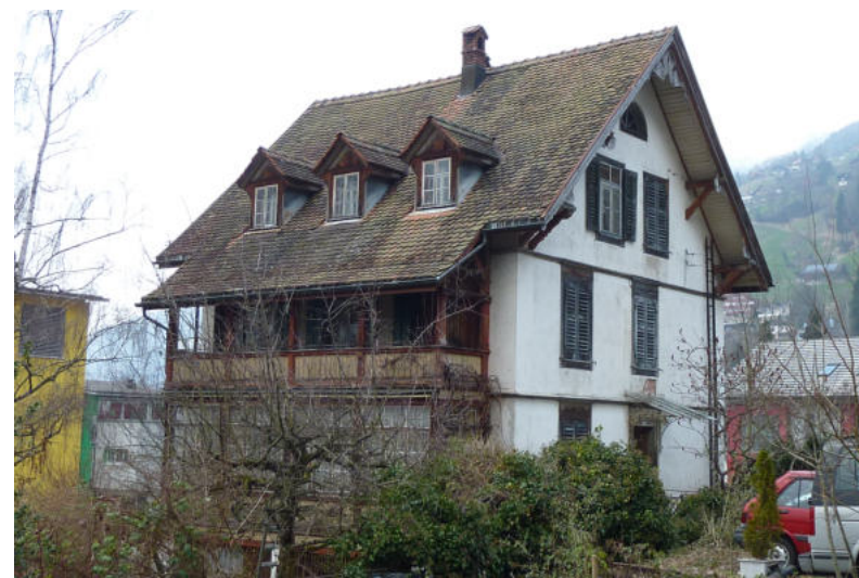
Meienrisliweg 2, Ansicht von SO (Aufnahme 2011)
