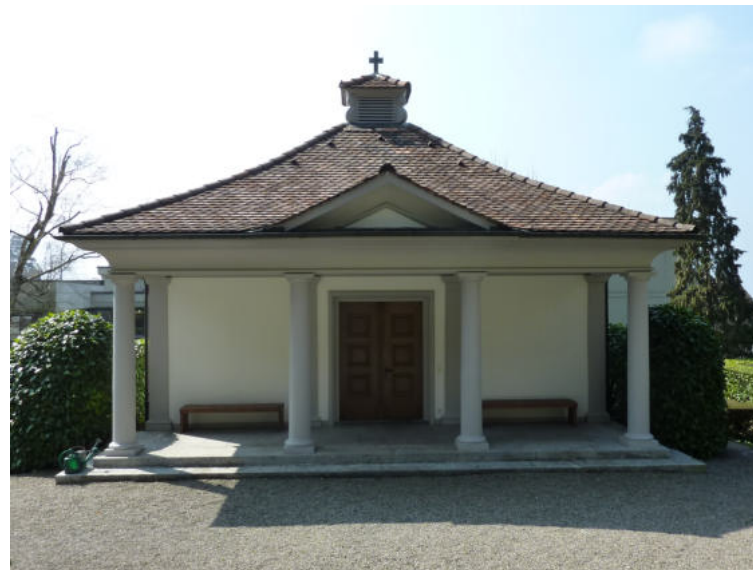
Zihlstrasse 8, Friedhof Abdankungshalle, Ansicht von NO (Aufnahme 2011)
