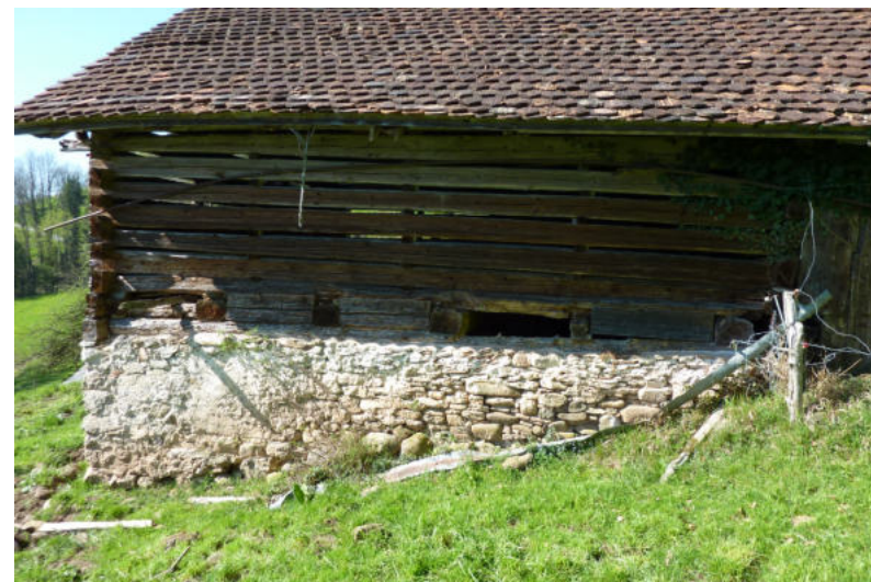
Wilenstrasse 43.2, Feldstall, Ansicht von SO (Aufnahme 2011)
