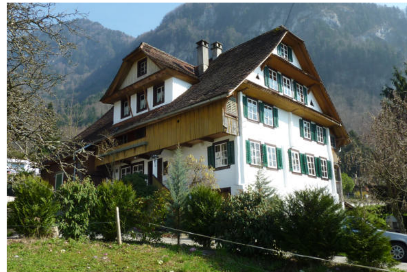
Unteraltdorfstrasse 5, Ansicht von NW (Aufnahme 2011)
