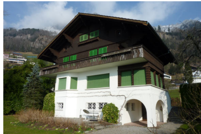
Seestrasse 46, Neu St. Romy, Ansicht von W (Aufnahme 2011)
