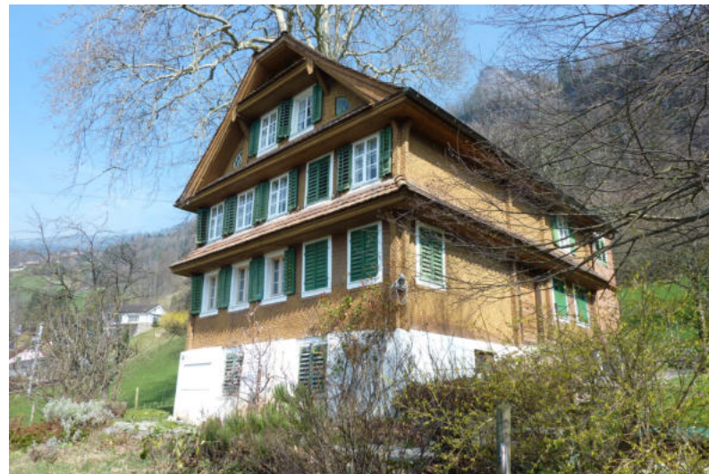
Bühlweg 3, Ansicht von S (Aufnahme 2011)
