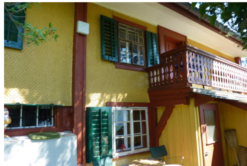
Reckholderwilenweg 1, Ansicht von NO (Aufnahme 2011)
