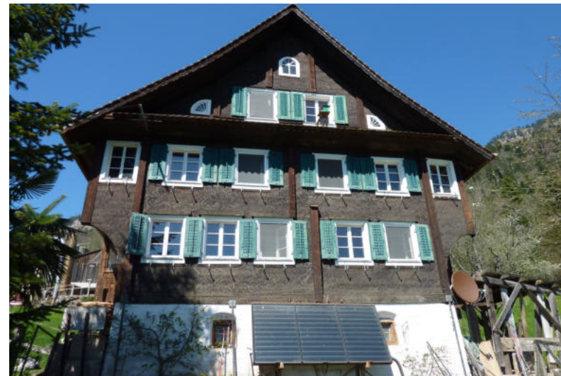
Wilenstrasse 45, Langwilen, Ansicht von S (Aufnahme 2011)
