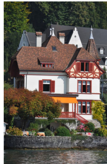
Seestrasse 16, Rosegütli, Ansicht von W (Aufnahme 2011)
