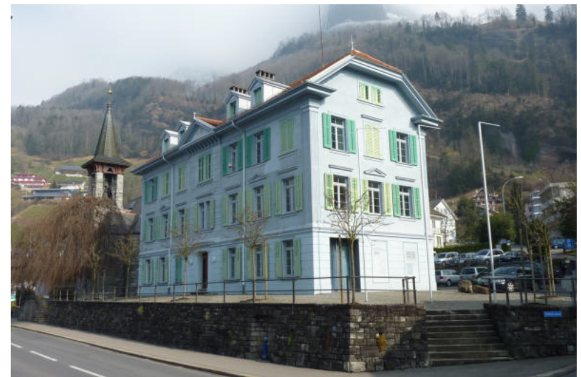
Zihlstrasse 1, Altes Schulhaus, Ansicht von SW (Aufnahme 2011)
