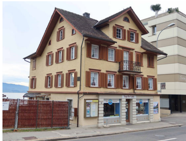
Seestrasse 56, Krämerhaus, Ansicht von SO (Aufnahme 2024)
