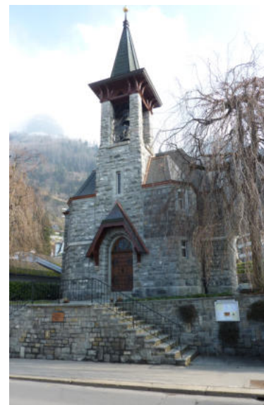
Seestrasse 61, Markuskirche, Ansicht von SW (Aufnahme 2011)
