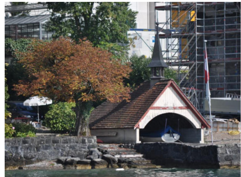
Seestrasse 16.1, Bootshaus Villa Rosegütli, Ansicht von NW (Aufnahme 2011)
