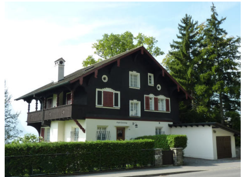
Seestrasse 6, Lausiegg, Ansicht von SO (Aufnahme 2011)
