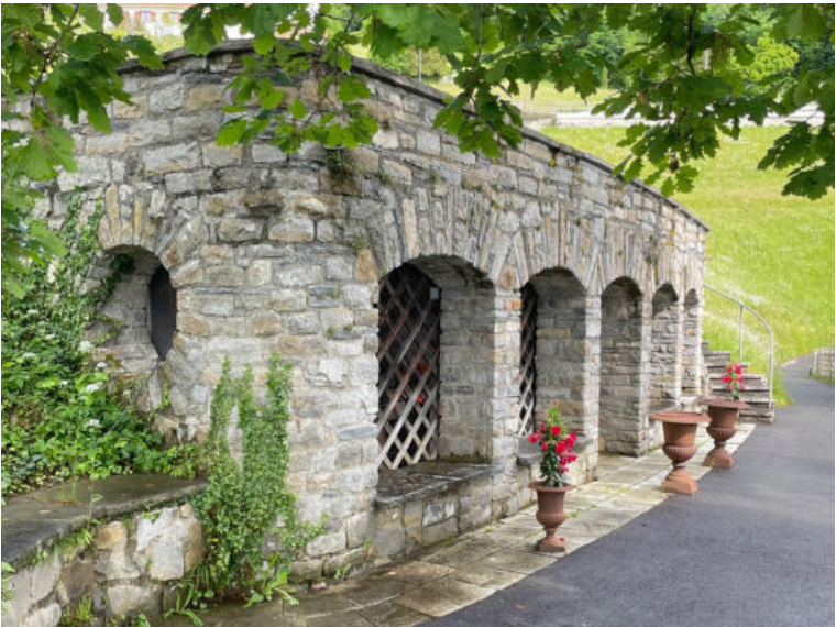
Seestrasse 110.4, Villa Margaritha, "Liegehalle", Ansicht von NW (Aufnahme 2024)
