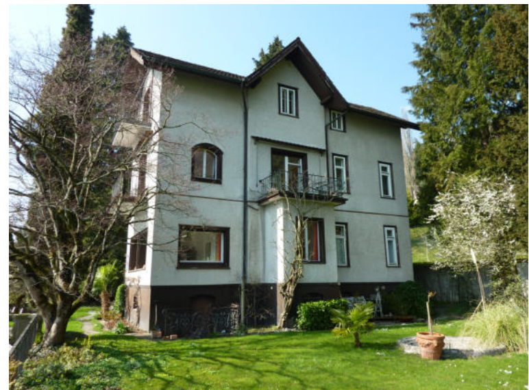
Seestrasse 10, Seehuus, Ansicht von SO (Aufnahme 2011)
