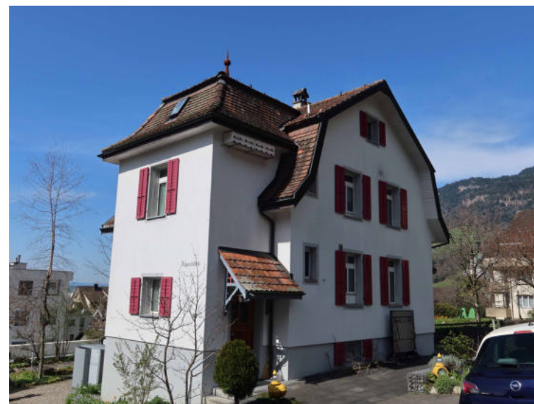
Hintergufferiweg 7, Alpenblick, Ansicht von SO (Aufnahme 2024)
