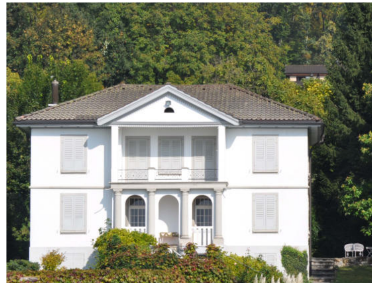
Seestrasse 82, Dossengrund, Ansicht von W (Aufnahme 2011)
