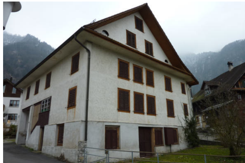
Oberkirchweg 3, Kleinerlen, Ansicht von NW (Aufnahme 2011)
