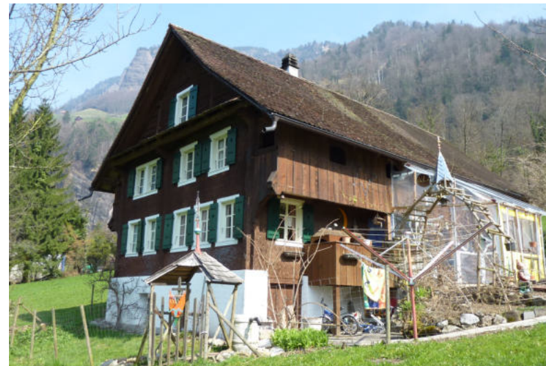
Stacherweg 11, Büntli, Ansicht von SW (Aufnahme 2011)
