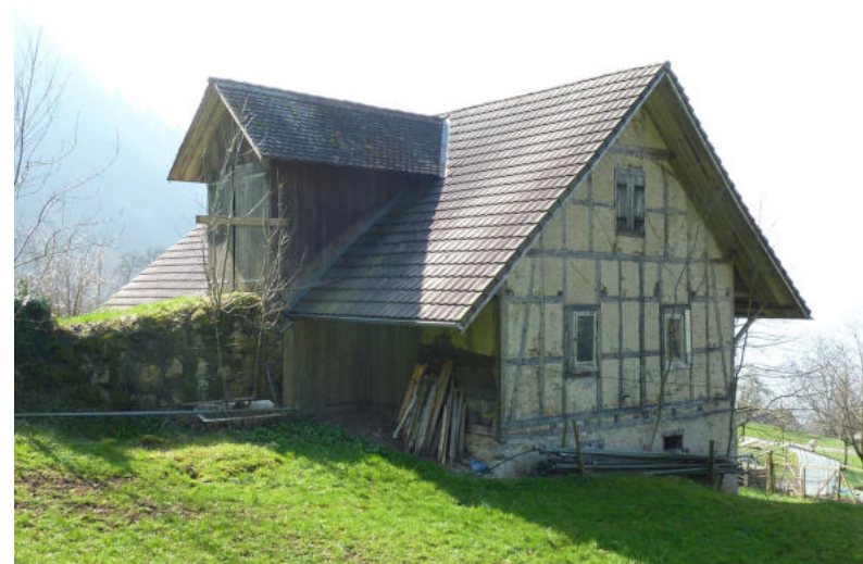
Stacherweg 11.1, Stall, Ansicht von NO (Aufnahme 2011)
