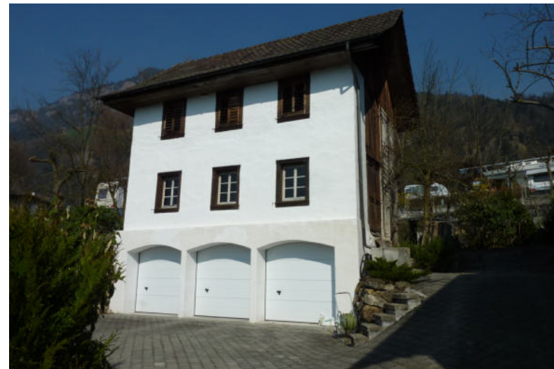
Unteraltdorfstrasse 5.1, Brennhaus, Ansicht von SW (Aufnahme 2011)
