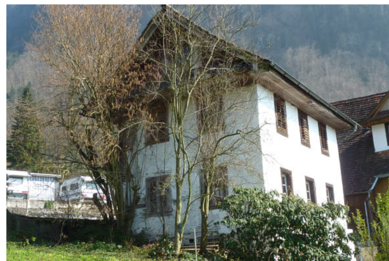
Unteraltdorfstrasse 5.1, Brennhaus, Ansicht von NW (Aufnahme 2011)
