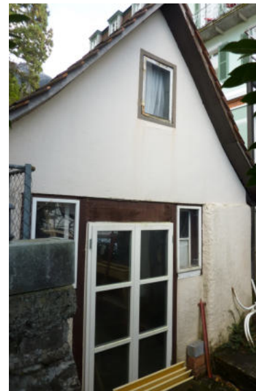
Seestrasse 62.1, Waschhaus, Ansicht von W (Aufnahme 2012)
