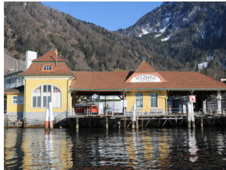
Bahnhofstrasse 4, Schiffstation Vitznau, Ansicht von W
