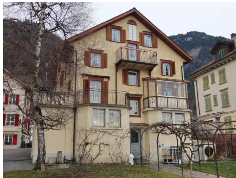
Seestrasse 56, Krämerhaus, Ansicht von W (Aufnahme 2024)
