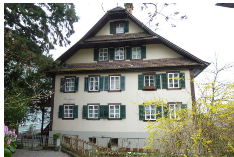
Seestrasse 62, Seerose, Ansicht von O (Aufnahme 2011)
