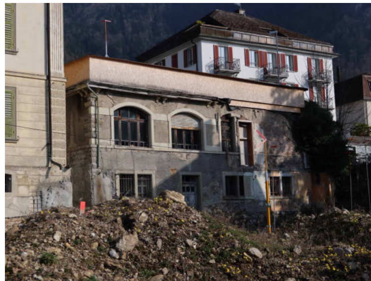
Seestrasse 60, ehemalige Post, Ansicht von NW (Aufnahme 2024)
