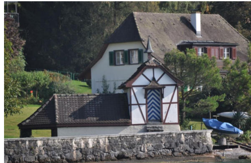
Seestrasse 84.2, Bootshaus Seewarte, Ansicht von N (Aufnahme 2011)
