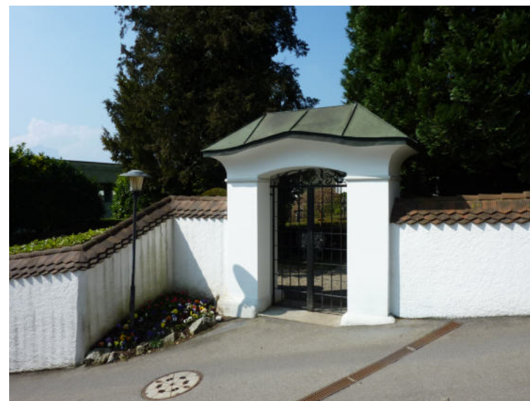
Zihlstrasse N.N., Friedhofsmauer, S-Portal (Aufnahme 2011)
