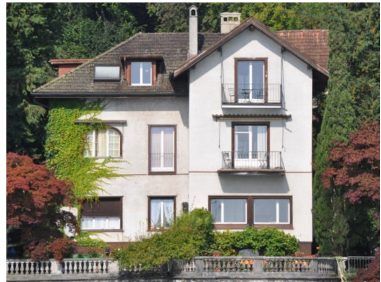
Seestrasse 10, Seehuus, Ansicht von W (Aufnahme 2011)
