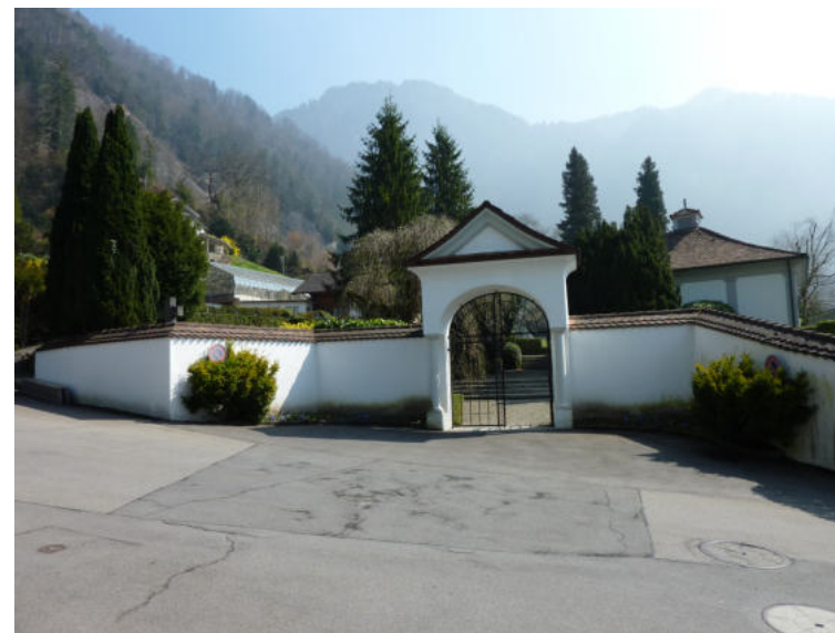
Zihlstrasse N.N., Friedhofsmauer, N-Portal (Aufnahme 2011)
