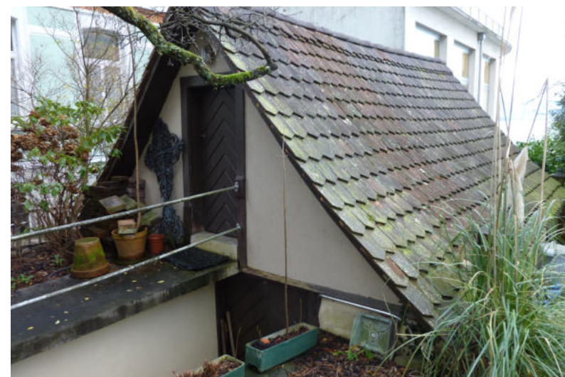
Seestrasse 62.1, Waschhaus, Ansicht von NO (Aufnahme 2012)
