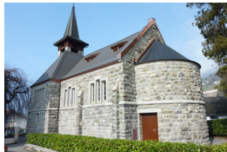
Seestrasse 61, Markuskirche, Ansicht von SO (Aufnahme 2011)
