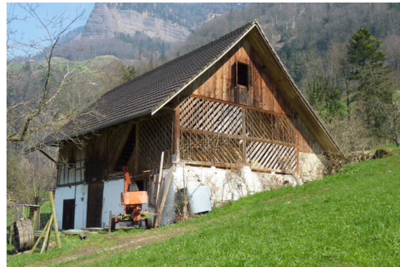
Stacherweg 11.1, Stall, Ansicht von SW (Aufnahme 2011)
