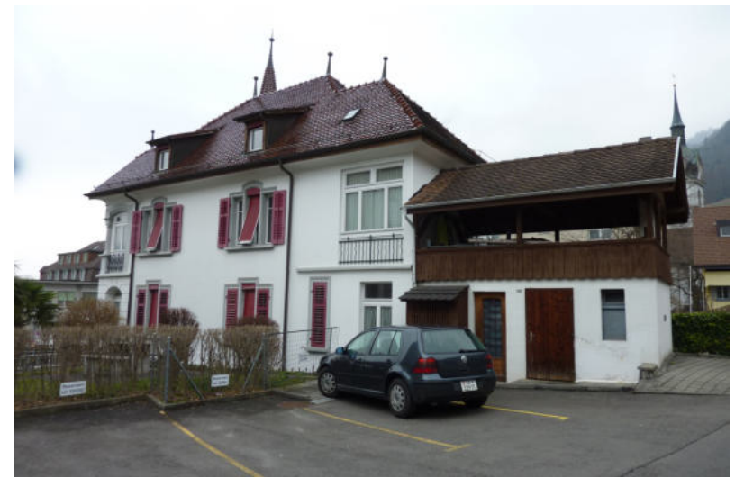
Seestrasse 67, Schlössli, Ansicht von SO (Aufnahme 2011)
