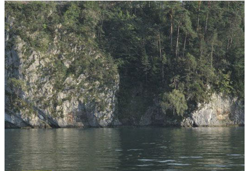
Sperrstelle Obere Nase, Ansicht vom See (Aufnahme 2011)
