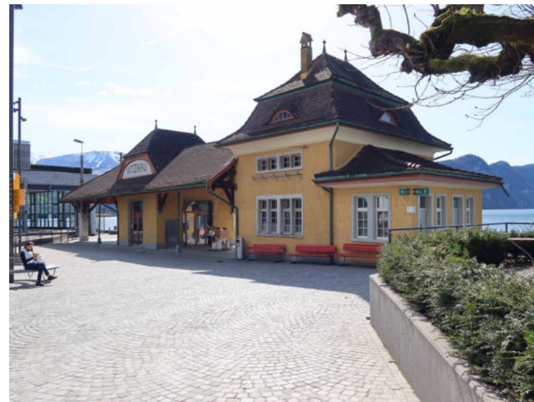
Bahnhofstrasse 4, Schiffstation Vitznau, Ansicht von NO (Aufnahme 2024)
