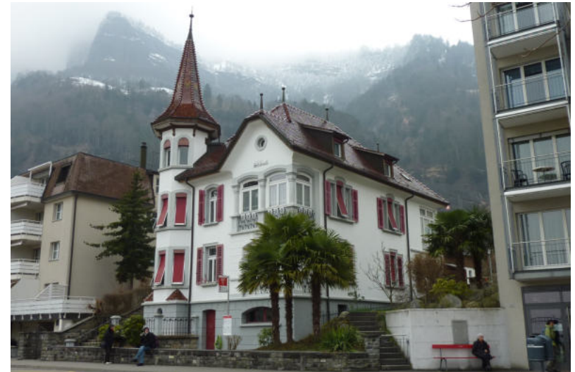
Seestrasse 67, Schlössli, Ansicht von SW (Aufnahme 2011)
