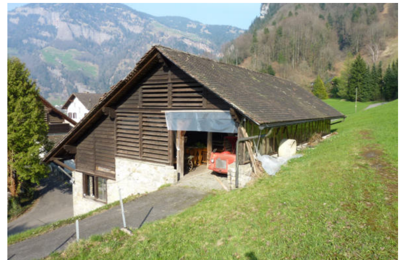
Schiberenstrasse 1.1, Flora Alpina, Ökononomiegebäude, Ansicht von SW (Aufnahme 2011)
