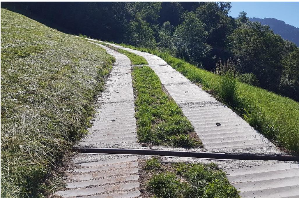
Abbildung 10: Verbautes "System Küttel" auf der Teststrecke Mittelschwanden, Vitznau
