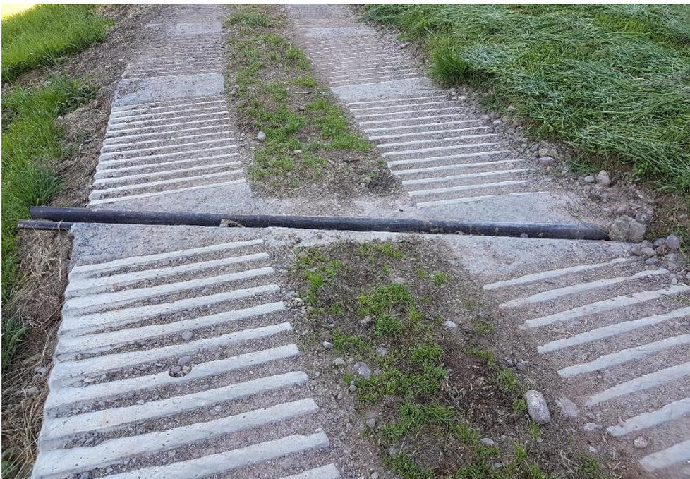
Abbildung 11: Querrinne im verbauten "System Küttel" auf der Teststrecke Mittelschwanden, Vitznau
